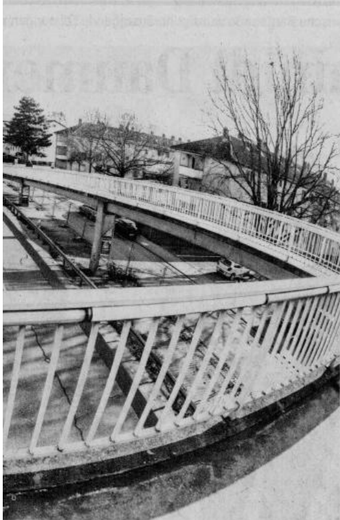
Standards nicht gegeben, weshalb ein Brückenneubau nötig wäre. Der kostet 100 000 Euro.
